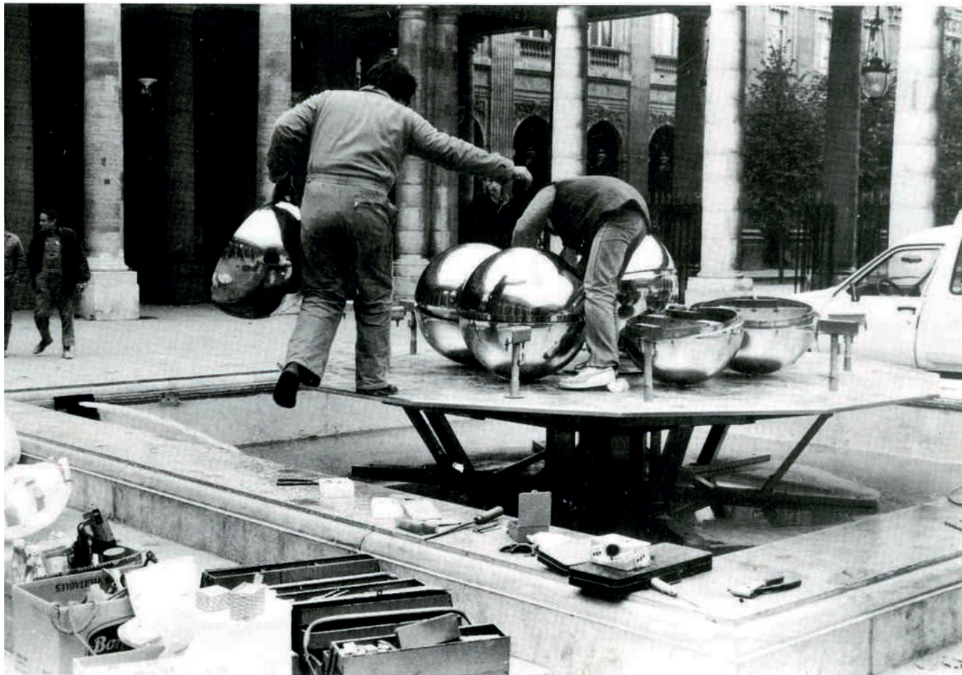
Pascal Gillard et Philippe Bouveret fixent les axes et les sphères sur une des vasques. Fontaines du Palais-Royal (Paris). ©Archives Pol Bury, Paris
